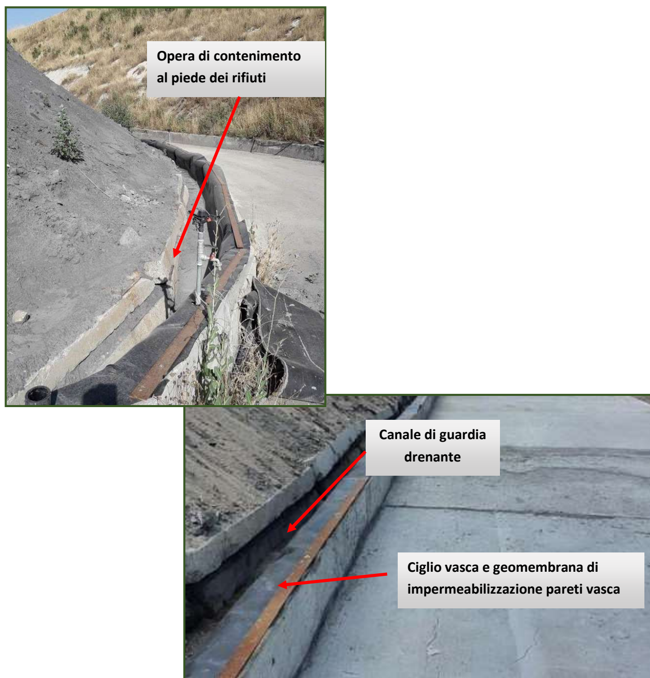
Figura 4.1/VII: Particolari opere di contenimento al piede
