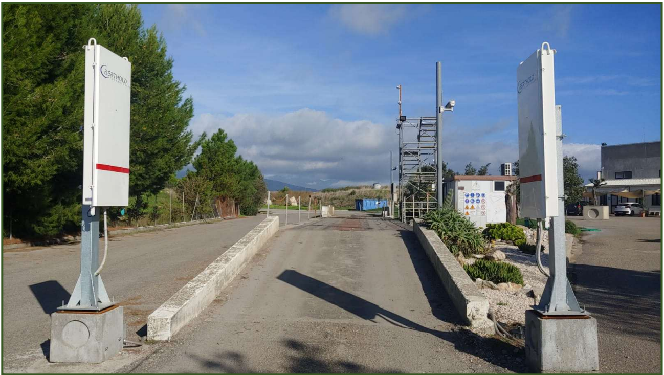
Figura 4.13/I: Portale radiometrico
