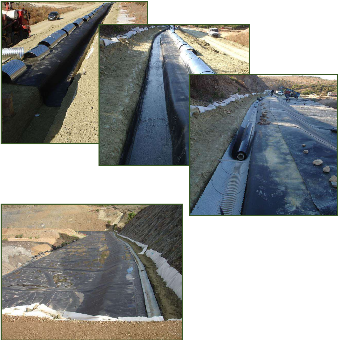
Figura 5.2/I: Esempio di immersione del telo in HDPE nelle canalette per la regimazione delle acque meteoriche di versante
