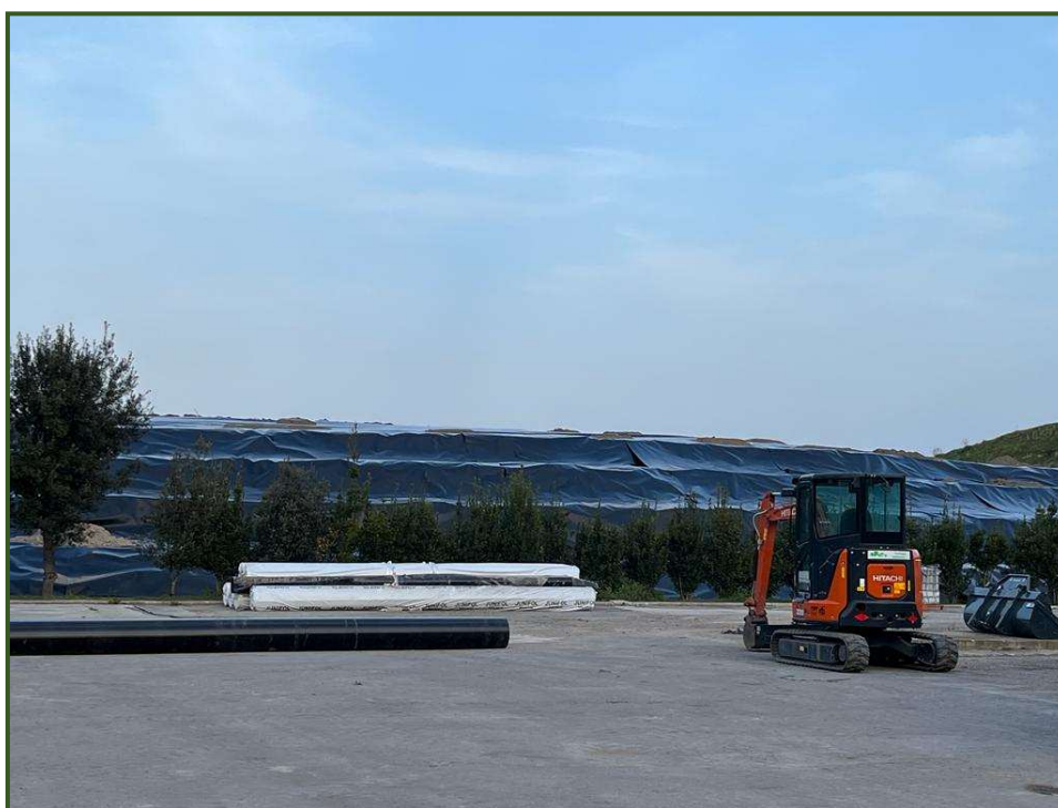
Figura 4.15/I: Chiusura provvisoria vasca V3
