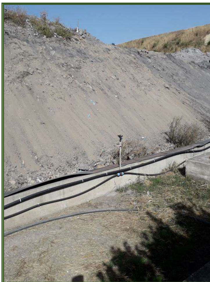
Figura 6.2/IV: Impianto fisso di irrigazione del paramento delle scarpate
