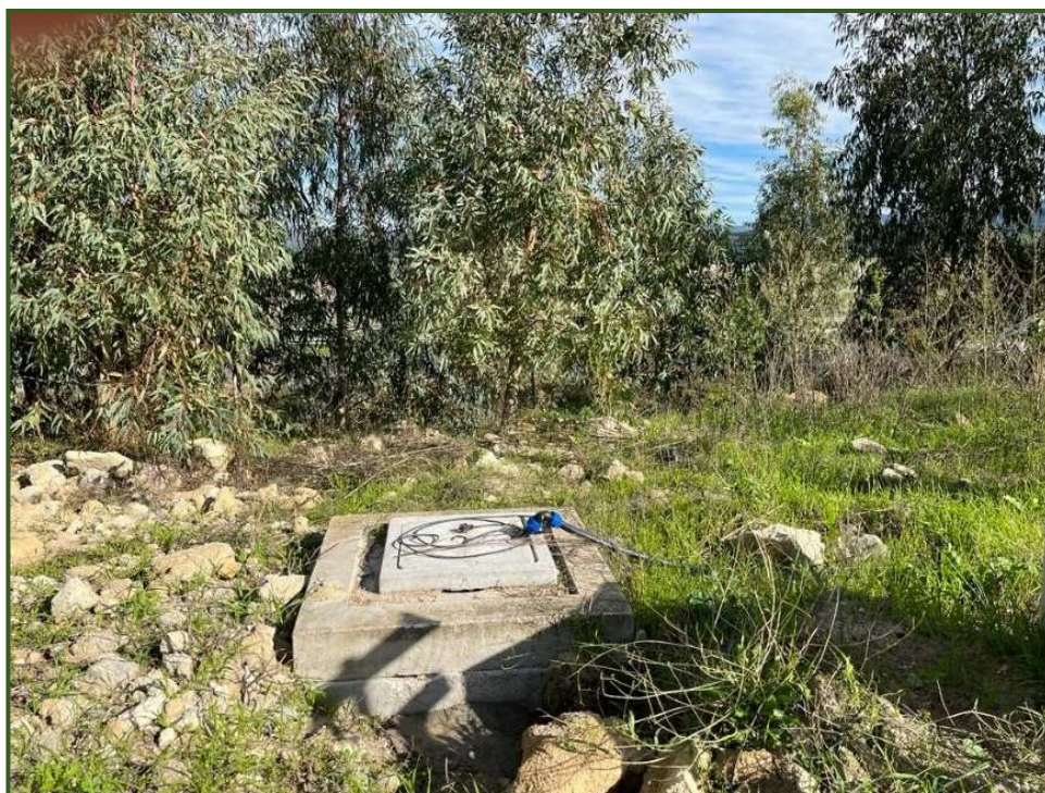
Figura 4.5/IV: Serbatoio di raccolta acque ricadenti su pista di servizio da immettere su sistema APP con sistema di pompaggi (vol. serbatoio 1000 l)
