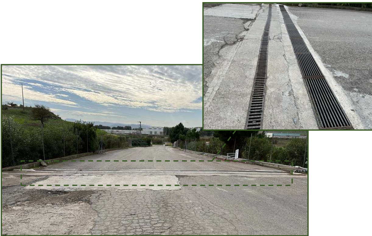
Figura 4.5/V: Grigliato raccolta acque prima pioggia aree pavimentate
